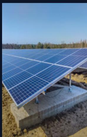
Cette solution unique est idéale pour les situations où des fondations vissées ou battues ne sont pas possibles, à cause de la présence d'une membrane d'étanchéité par exemple (CET). Offrant une adaptabilité exceptionnelle aux défauts de nivellement du terrain, elle permet à la structure d'évoluer avec les changements topographiques du terrain (tassement différentiel). Elle apporte aussi une solution à des contraintes particulières telles que la présence d'infrastructures souterraines.
